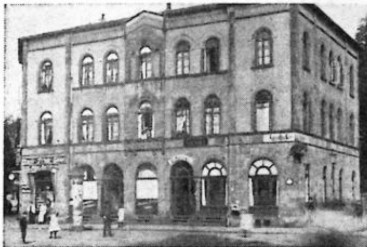
DIE ERSTE ADLER-APOTHEKE stand am Schillerplatz 7, wo heute das Gebäude der Bank für Gemeinwirtschaft ist.
