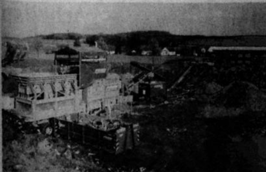
DAS BAUSCHUTT-RECYCLING zählt ebenfalls zum Leistungsspektrum der Firma Frye. Unsere Aufnahme zeigt eine moderne Recyclinganlage in Melle-Oldendorf.
