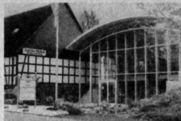
REIZVOLLER KONTRAST zwischen Alt und Neu. Werkstatt und der Neubau an der Osnabrücker Straße in Bissendorf. Fotos: hopp
