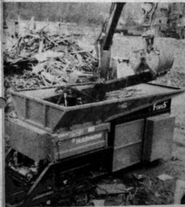
EIN HOLZBRECHER des Unternehmens auf einer der zahlreichen Baustellen in Aktion.
