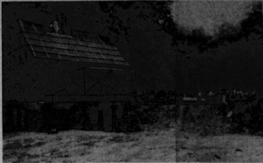
EIN altes Haus kommt zu neuen Ehren: Das ehemals an der Burschen Straße in Melle-Mitte gelegene Fachwerkhaus dient künftig als Müllerhaus am Mühlenleich in Ostenwalde. Jetzt wurde nach alter Väter Sitte Richtfest gefeiert. Foto: J. Wildt
