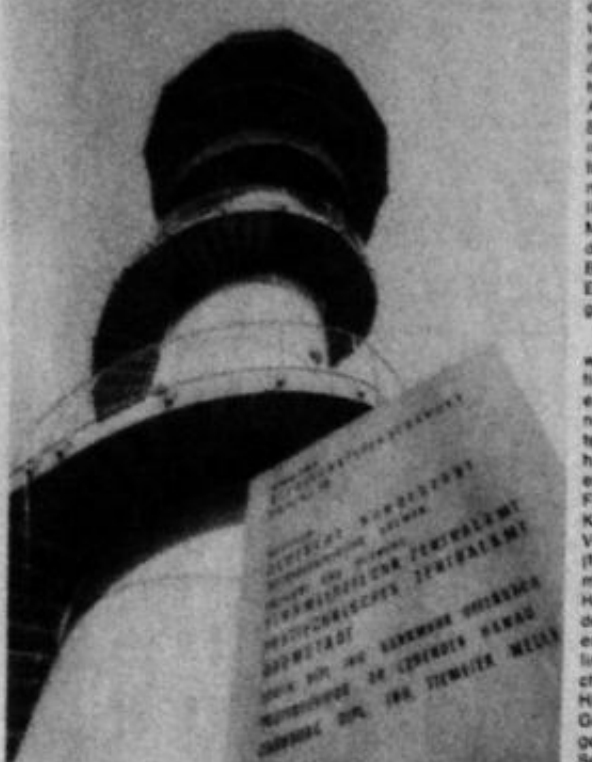
Blick hoch zum Ferkelsturm: Zu Beginn der 80er Jahre stehen in Dissen auch die ISDN-Anschlüsse der Bundespost zur Verfügung.
