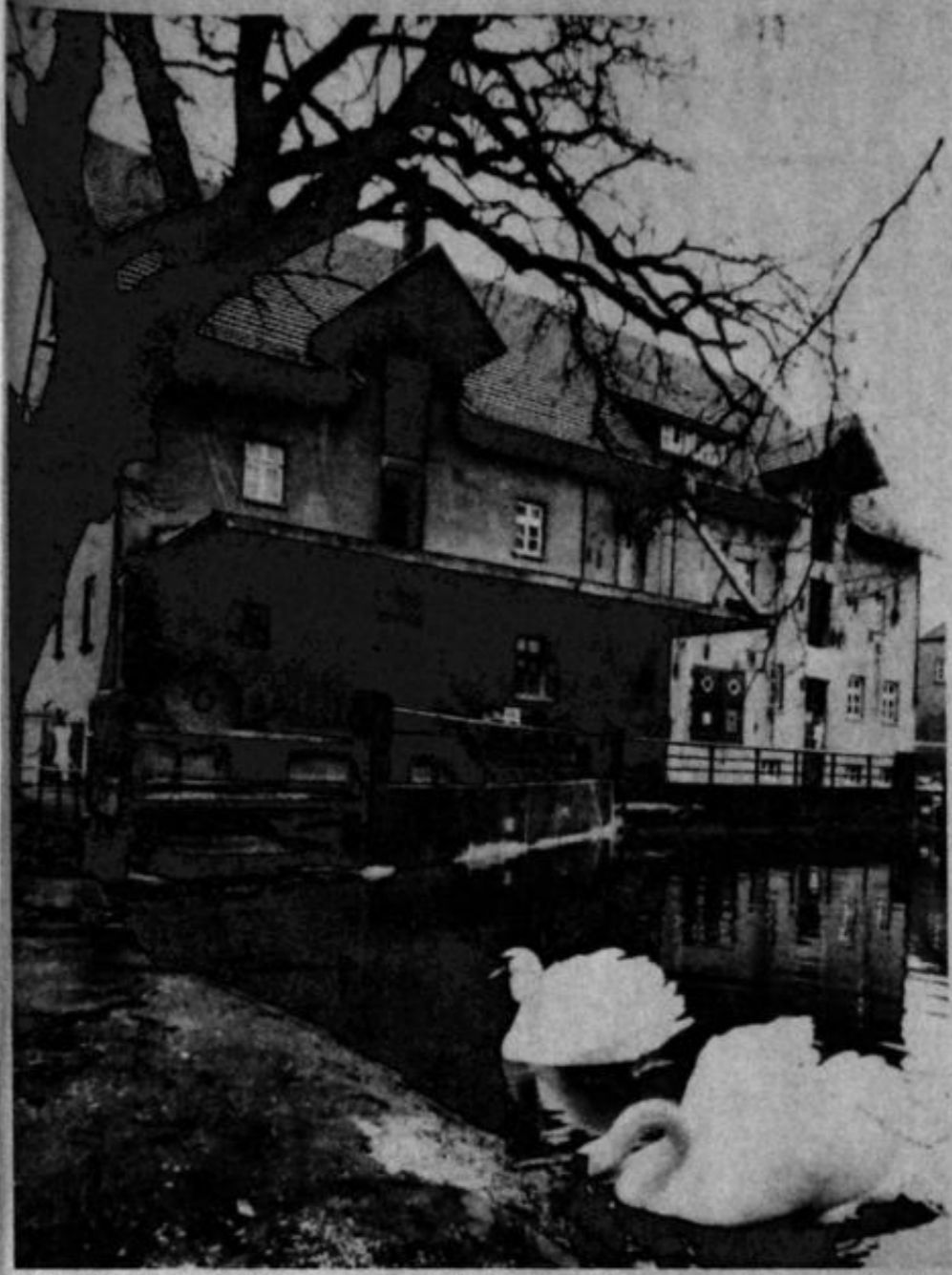
ZWEI FLIEGEN mit einer Klappe schlägt die wieder in Betrieb genommene Wassermühle auf dem Mersch: Sie erzeugt genügend Energie, um die Hammermühle für das Tierfutter zu betreiben (die Feinmehlherstellung aus Getreide wurde 1958 eingestellt, jetzt wird vor allem Mischfutter produziert) und liefert umweltfreundlich gewonnenen Strom für den eigenen Haushalt wie für das öffentliche Netz.
